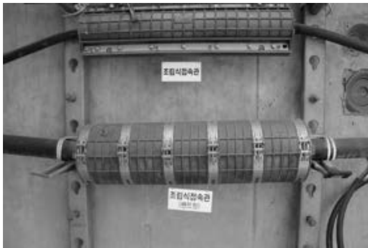
[그림 3-3] 인공 내 접속함 설치(예시)
