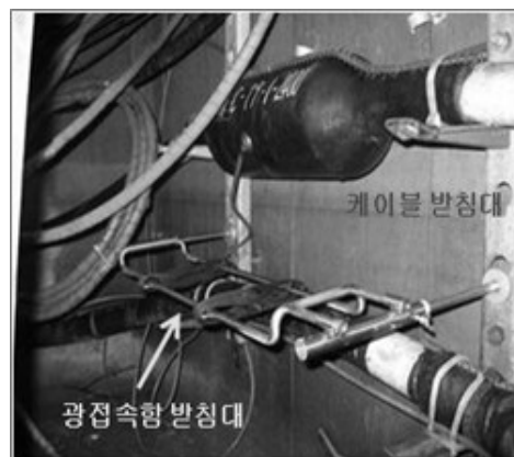
[그림 4-1] 작업준비(받침대)(예시)
