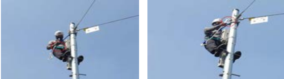
[그림 2-18] 안전대 착용 및 고정(예시)
