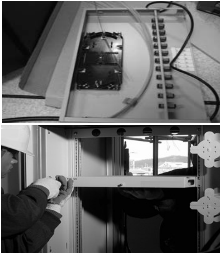
[그림 5-1] 장치가에 광분배함 설치(예시)
