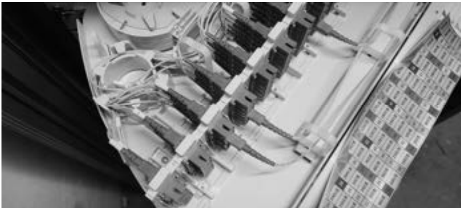
[그림 5-5] 접속판내 보호튜브 삽입(예시)
