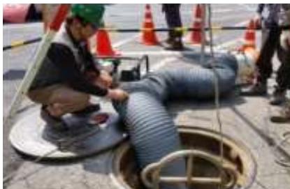
[그림 2-8] 산소 및 유해가스 농도 측정기 및 환기장치
