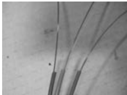
[그림 3-7] 케이블 탈피 및 루즈튜브 제거(예시)
