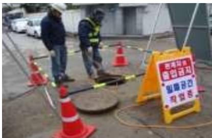
[그림 2-9] 안전 표지판 및 출입금지 조치(예시)
