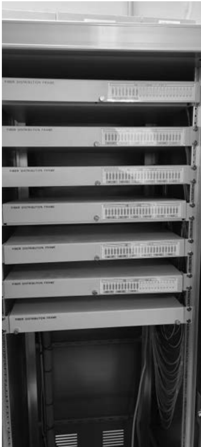
[그림 5-2] 광분배함 의 광단국장치 및 장치가에 실장(예시)
